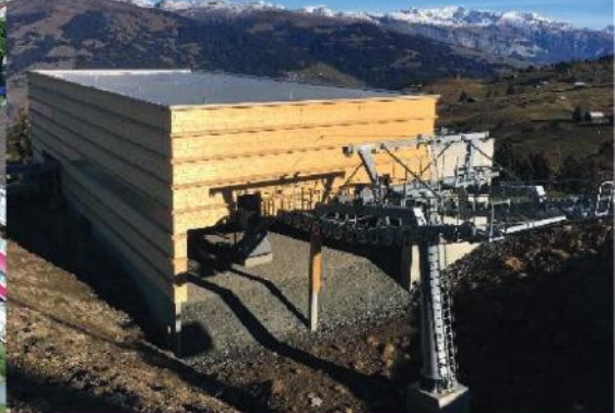
Neubau Sesselbahn, Obersaxen
